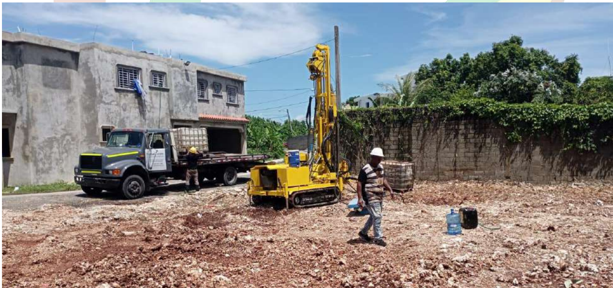
Fig. 16 Equipo de perforación TP-50 TECOINSA utilizado
