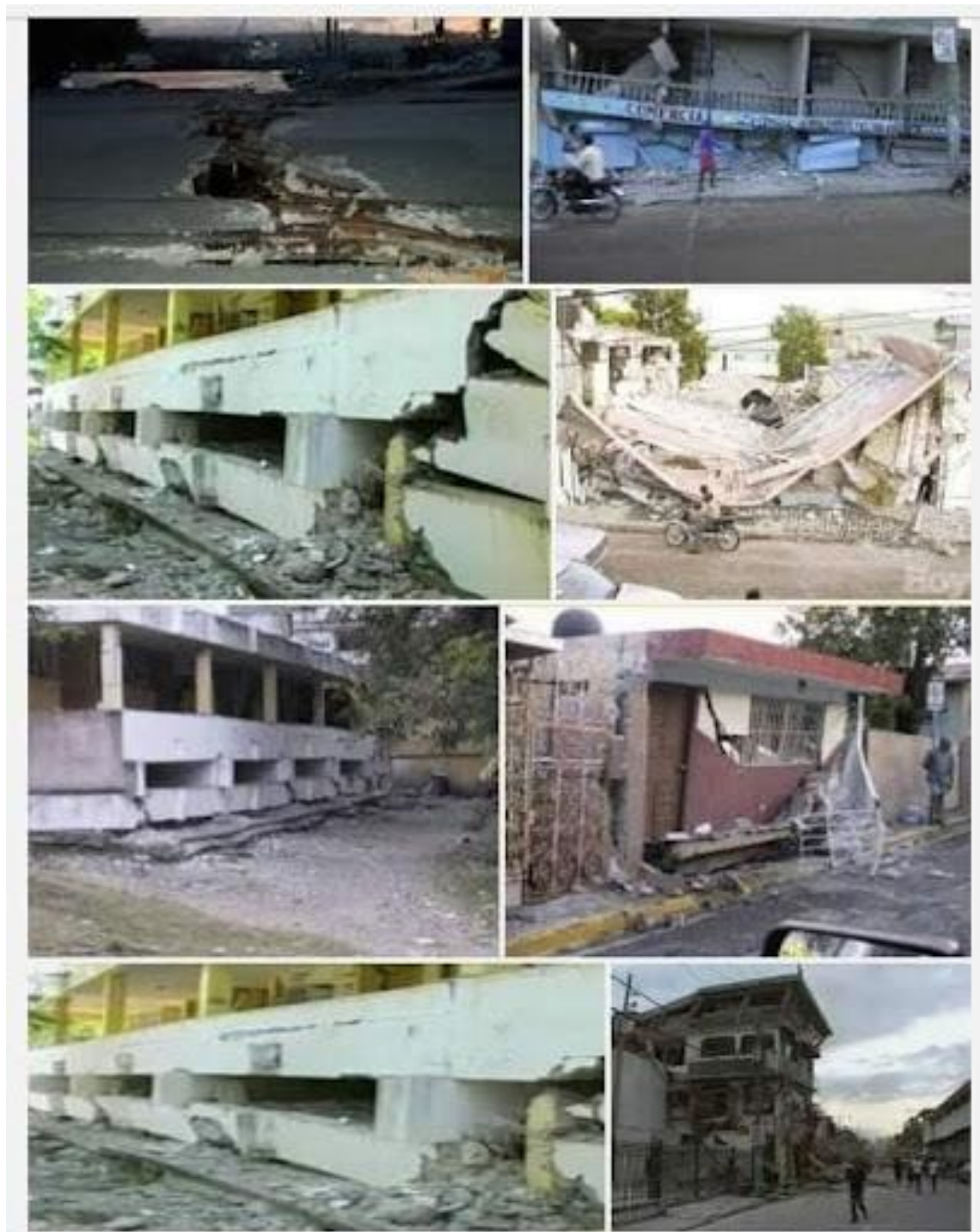
(Fotos Sismo en Puerto Plata 2003)
